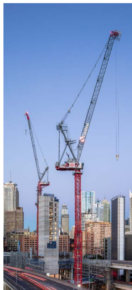
Der J780PA beim Einsatz auf der Baustelle „The Ribbon“ in Sydney
